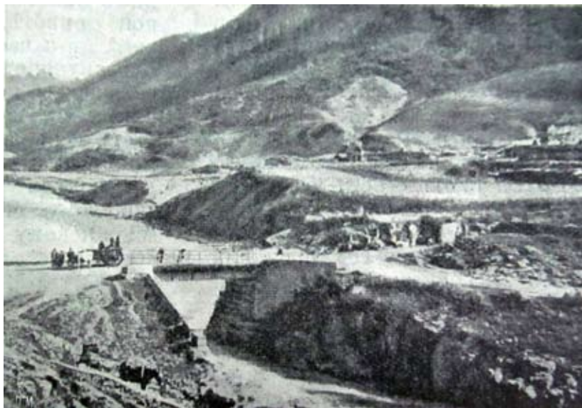
Міст через р. Кубань поблизу аулу Кам'яноміського
